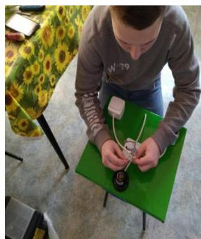
Делается технологическое отверстие, подключаются проходные переключатели, цоколь, электрическая вилка для подключения к источнику тока.
